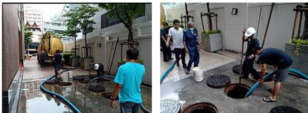
ภาพที่ 2-8 การสูบน้ำจากตะกอนส่วนเกินจากระบบบำบัดน้ำเสีย
