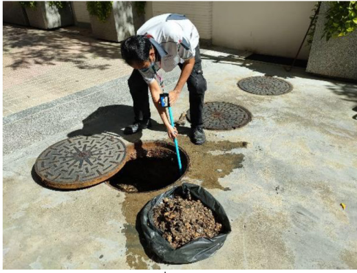
ภาพที่ 2-23 ช่างอาคารตรวจสอบบ่อดักไขมัน และทำความสะอาด
